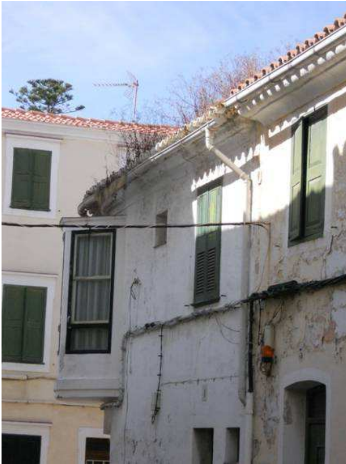
Ilustración 1- Edificios deteriorados en el centro de Mahón-Maó
